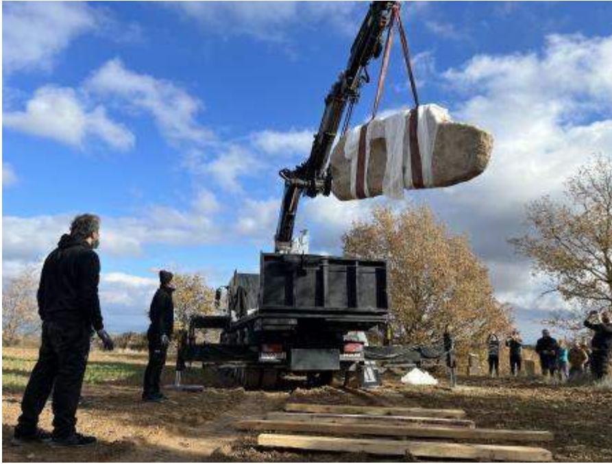
Una grua descarga la estatua menhir del Roc de la Mare de Déu de Riner ACN
